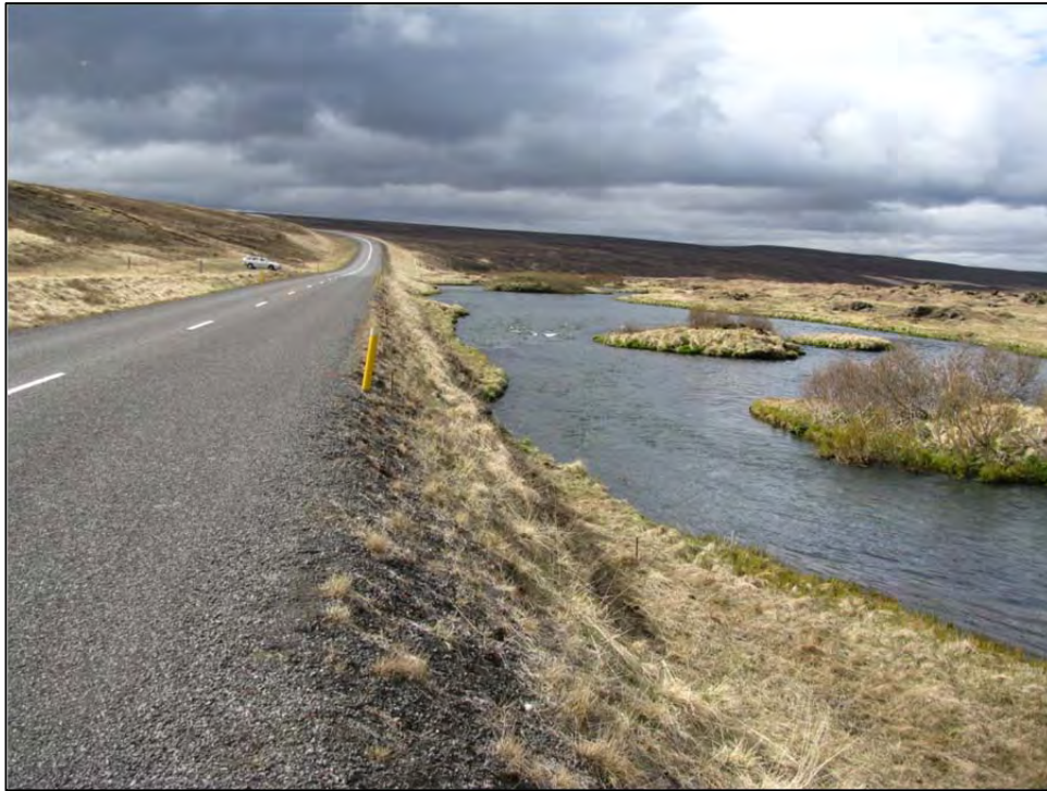
Mynd 5. Hættulegur vegkantur á bökkum Laxár þar sem komið er ofan af Mývatnsheiði.
