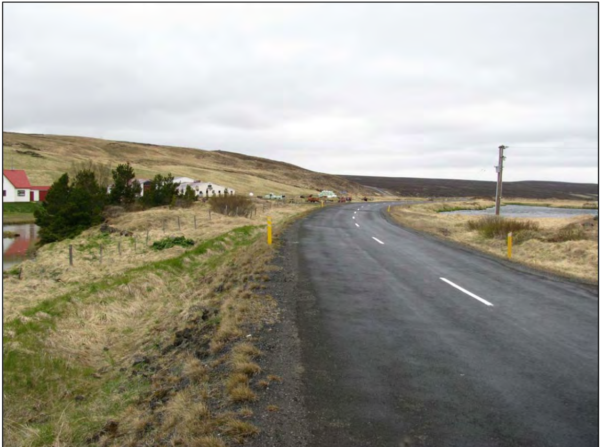
Mynd 8. Við upphaf framkvæmdakafans að sunnanverðu. Við hlið vegarins sést hitaveitulögnin.
